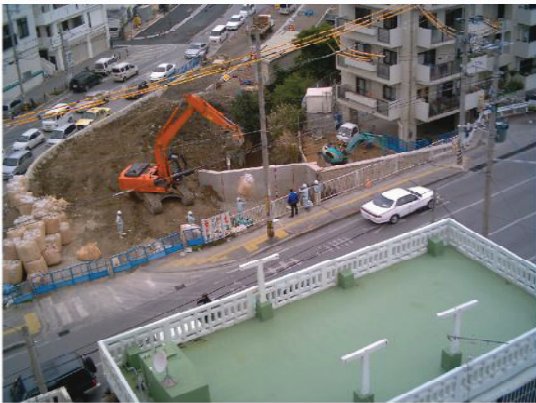
↑ 工事現場外観
