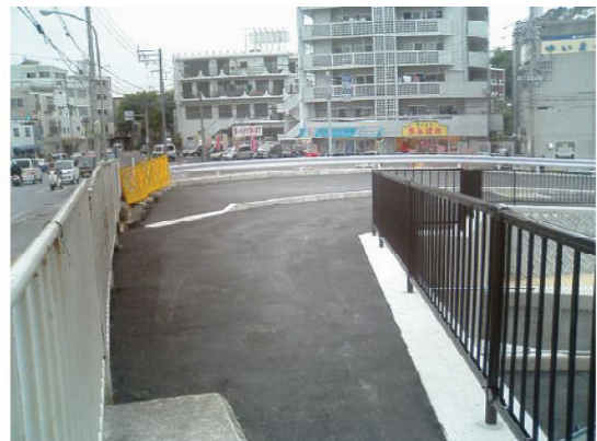
↑ 施工後 完成写真
