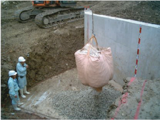
↑ スーパーソル投入状況
