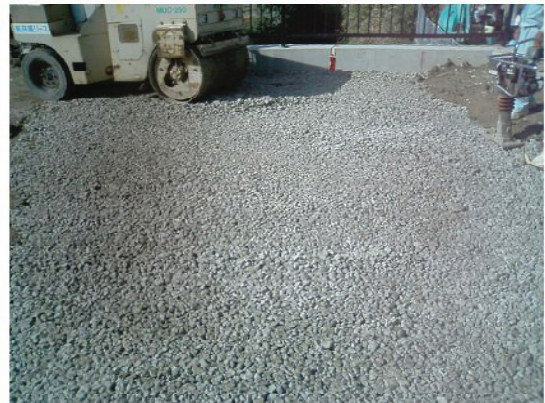
↑ スーパーソル振動ローラーによる転圧
