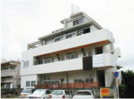
▲住宅（屋上に施工）
